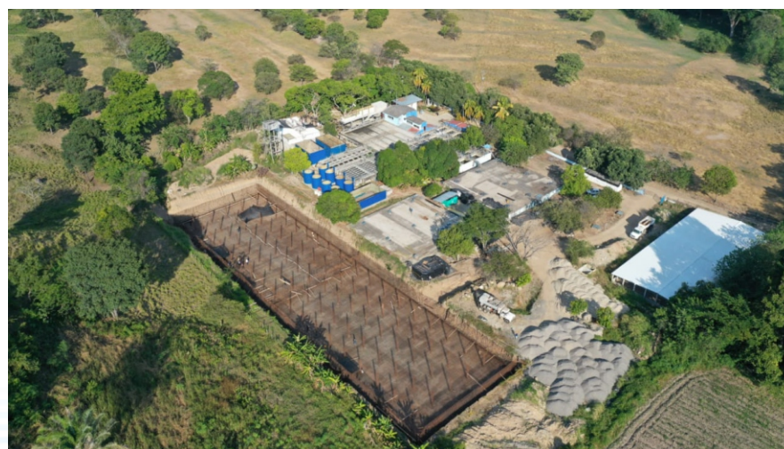
Archivo avance de obras Aguachica
