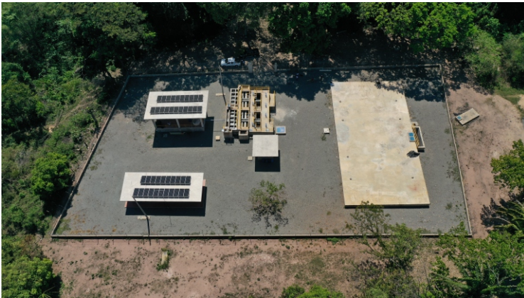
Planta de Tratamiento de Agua Potable
