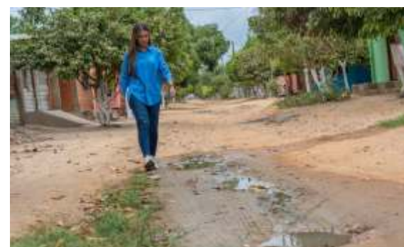
Así se ven las calles de Mandinguilla por la ausencia de alcantarillado sanitario, pero esto llegará a su fin gracias al proyecto que allí se ejecutará.
