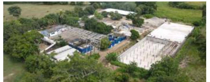
La gobernadora del Cesar, Elvia Milena Sanjuan Dávila, recorrió los distintos puntos que integran los proyectos de acueducto que se vienen ejecutando en Aguachica.
