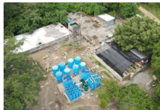
Con la optimización del acueducto urbano de San Alberto se impacta en la continuidad y calidad del servicio en el casco urbano.
