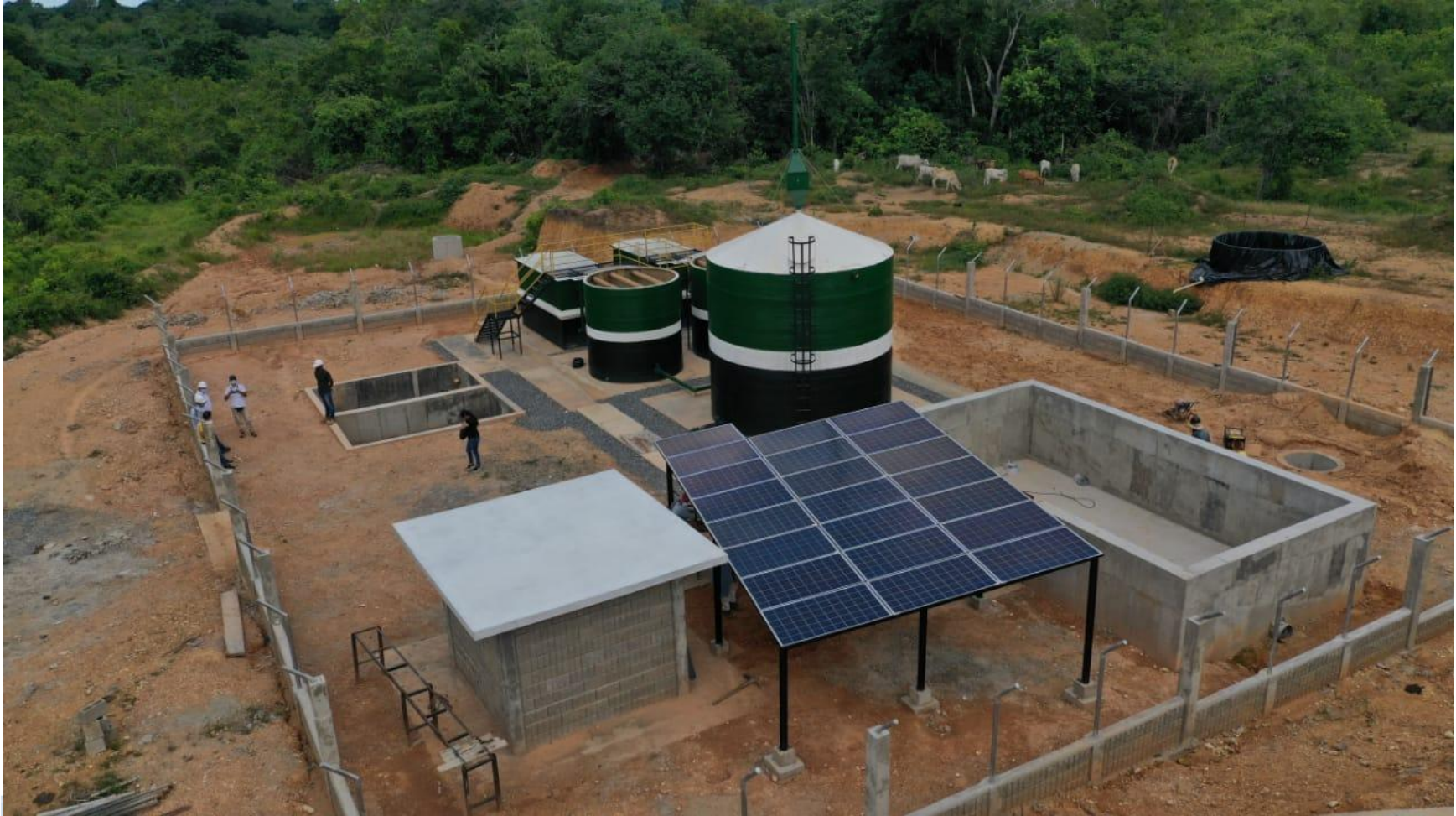
Acueducto y Alcantarillado Palestina
