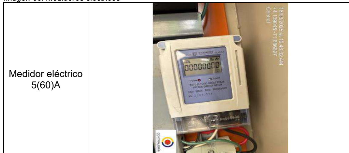
Imagen 66. Medidores eléctricos
