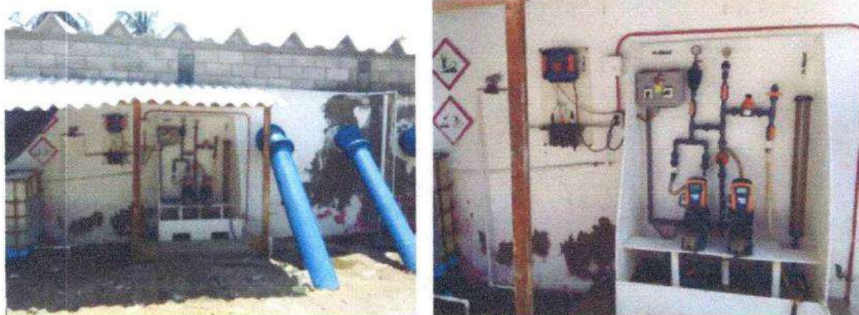
Ilustración 2 Ubicación modulo dosificador de hipoclorito tanque de rebombeo Fuente: Documento “DOC EBAP GAIRA”
