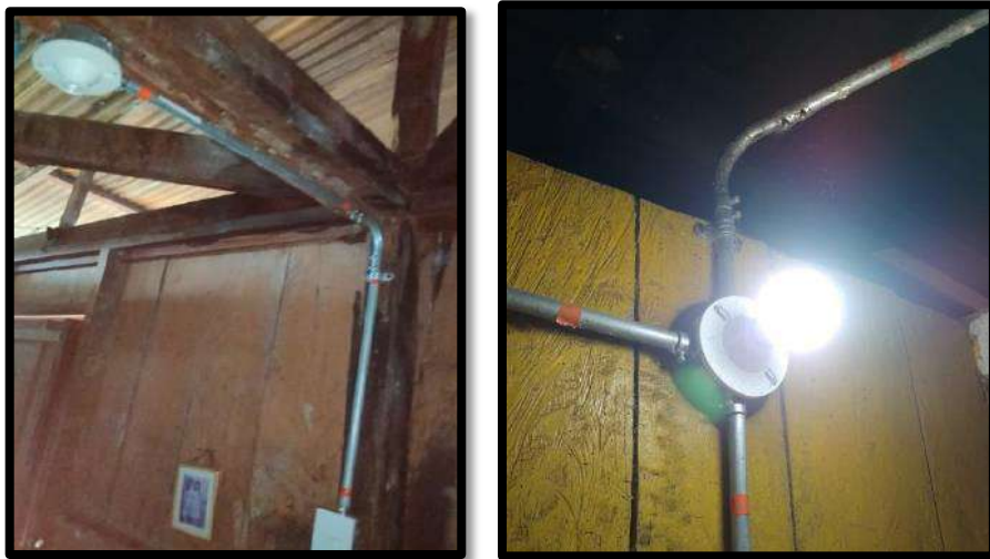
Imagen. 59. Instalación de abrazadera 1/2" doble ala
