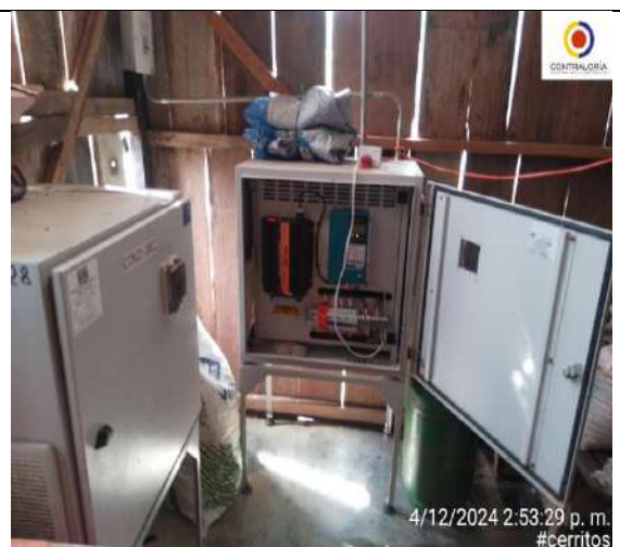
Imagen 47. Traslado de equipos entre unidades de vivienda.
