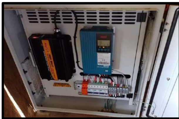
Foto 56. Panorámica de gabinete instalado.
