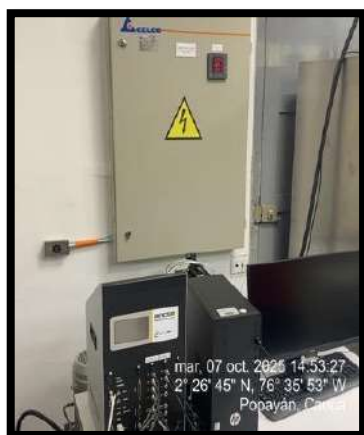
Imagen 77 Tablero eléctrico.
